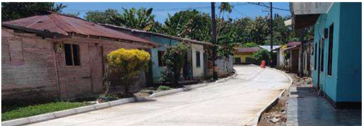
Pavimentación vía Urbana. Bajo Cauca, Municipio de Cáceres. Secretaría de Infraestructura Física.
