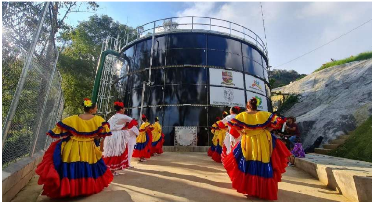
Construcción tanque de almacenamiento de acueducto Suroeste de Antioquia, municipio de Jericó. Gerencia de Servicios Públicos.
