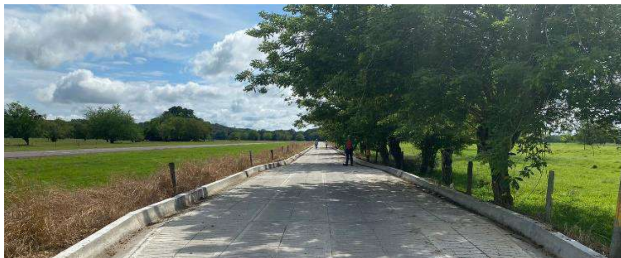
Placa Huella en la Vía La Ye De Casanare - La Pesca - La Sierra. Magdalena Medio, Municipio de Puerto Nare. Secretaría de Infraestructura Física.
