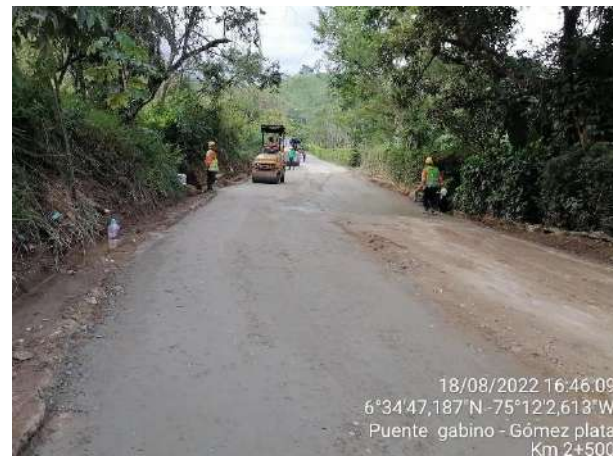
Conformación de calzada vía 25AN08 Santa Rosas de Osos (Ruta 25) - Malambo - San Pablo - Puente Gavino. Norte, municipio de Santa Rosa. Secretaría de Infraestructura Física.
