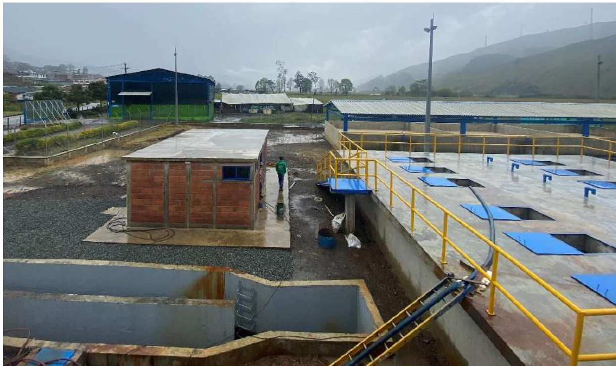
Construcción de planta de tratamiento de aguas residuales y redes de alcantarillado. Suroeste de Antioquia, municipio de Urrao. Gerencia de Servicios Públicos.
