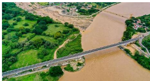
Nuevo Puente sobre el río Cauca, reemplazará el existente Puente Amarillo o Paso Real, inaugurado en 1965. Nordeste, Municipio de Santo Domingo Concesión Autopista al Mar 1.
