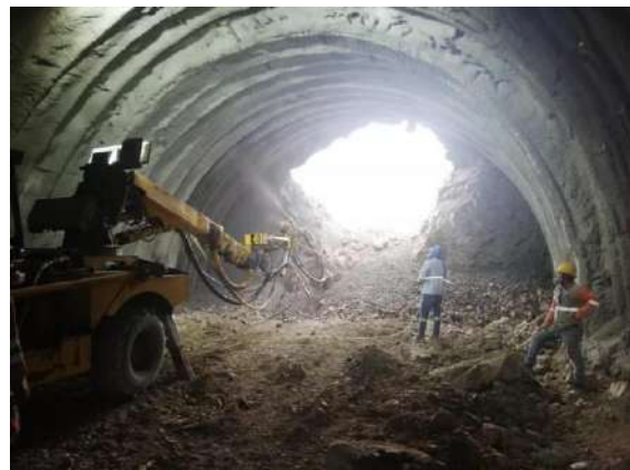
Cale Túnel 11. Occidente, Municipio de Cañasgordas y Giraldo. Secretaría de Infraestructura Física.
