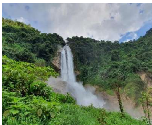
PCH Generadora La Cascada Oriente, municipio de Abejorral Instituto para el Desarrollo de Antioquia – IDEA
