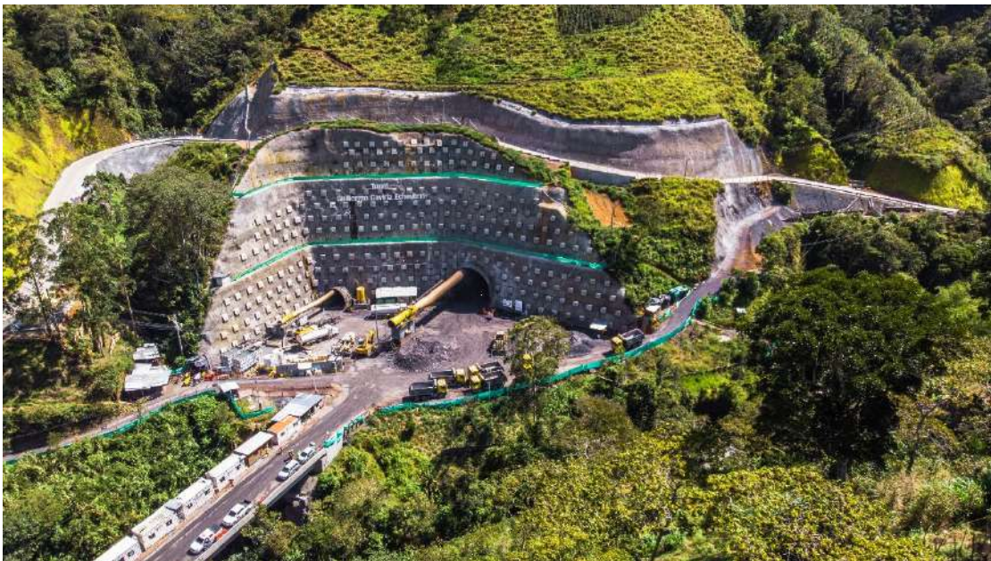
Cumplimiento con las metas de recaudo en los ingresos para la ejecución de los programas y proyectos del Plan de Desarrollo del Departamento de Antioquia Túnel Guillermo Gaviria Echeverri Secretaría de Hacienda
