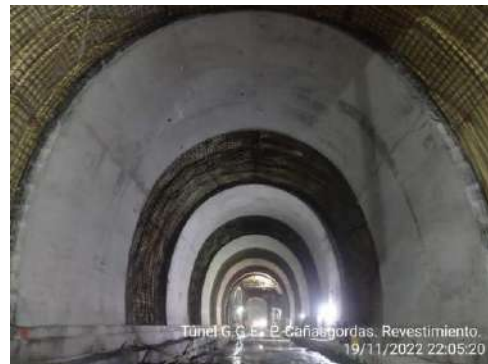
Revestimiento definitivo portal Cañasgordas. Occidente, Municipio de Cañasgordas. Secretaría de Infraestructura Física.
