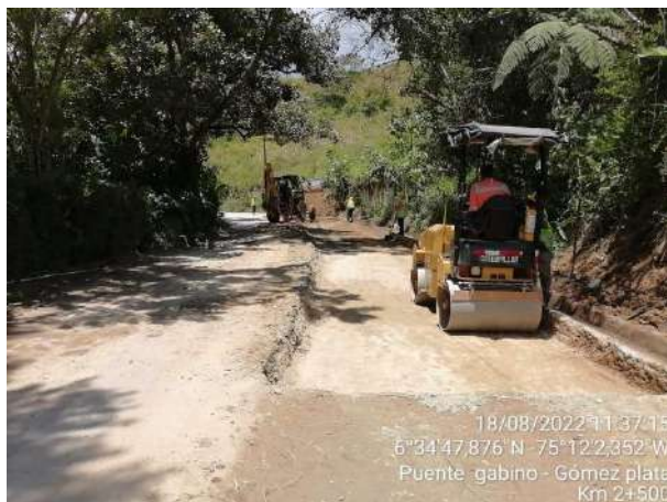
Conformación de calzada vía 25AN08 Santa Rosas de Osos (Ruta 25) - Malambo - San Pablo - Puente Gavino. Norte, municipio de Santa Rosa. Secretaría de Infraestructura Física.
