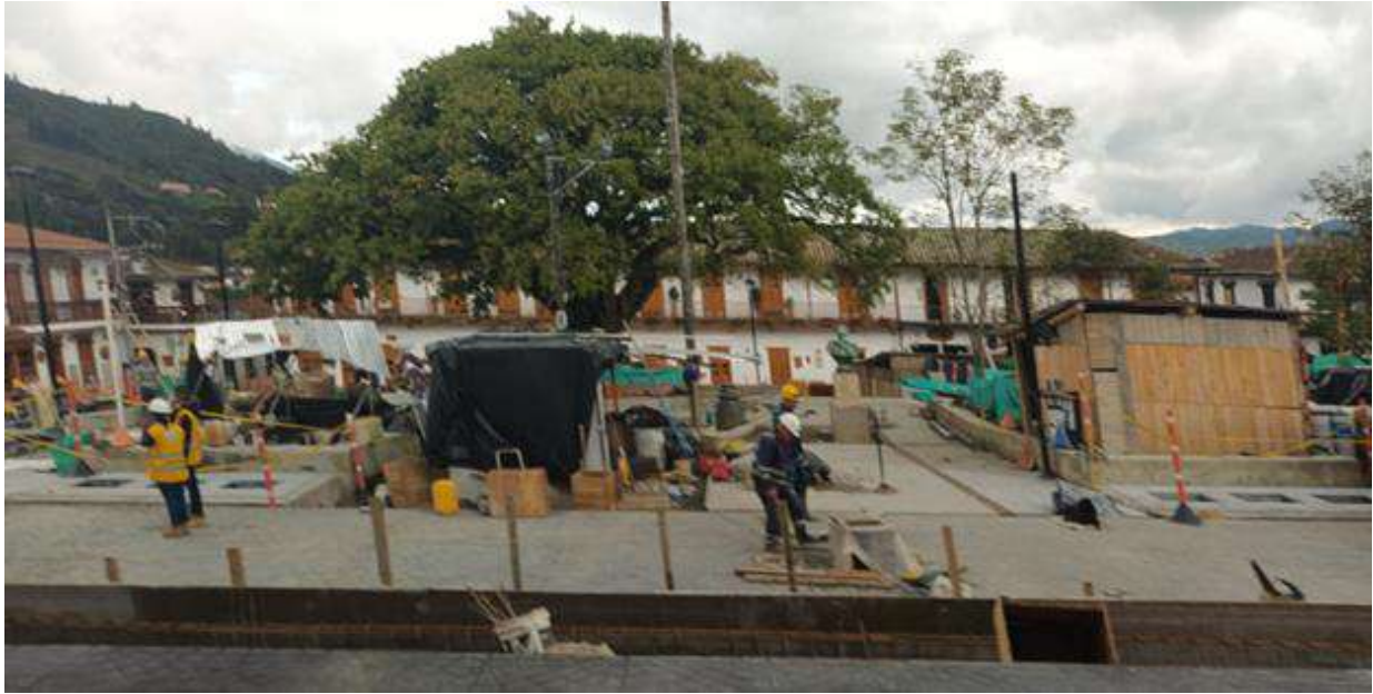
Parque Principal Municipio de El Retiro. Oriente, Municipio de El Retiro. Secretaría de Infraestructura Física.
