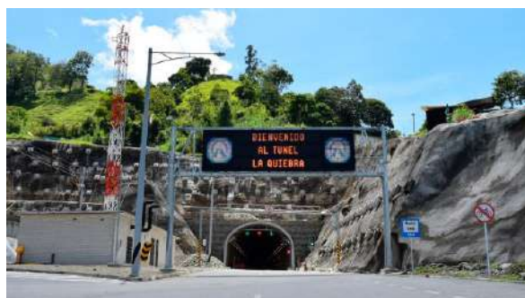
Túnel de la Quebra. Nordeste, Municipio de Santo Domingo Concesión Vías del Nus.
