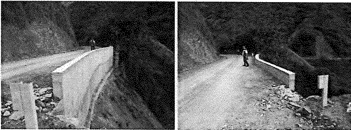
Fotos: VIA LIBORINA – SABANALARGA, Fuente: registro fotográfico marzo de 2014. Elaboró: Elkin Darío Vásquez Valencia, P.U.
