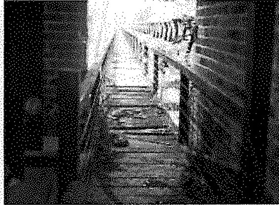
DETERIORO EN LAS TORRES Y ZONA PEATONAL, MADERA PODRIDA, Y EN ALGUNAS PARTES SIN TABLONES
