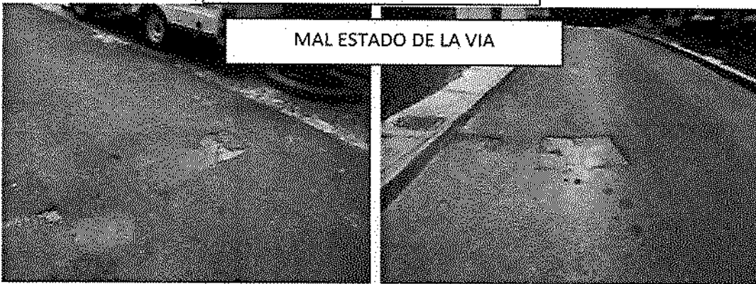
DETERIORO EN EL PAVIMENTO
