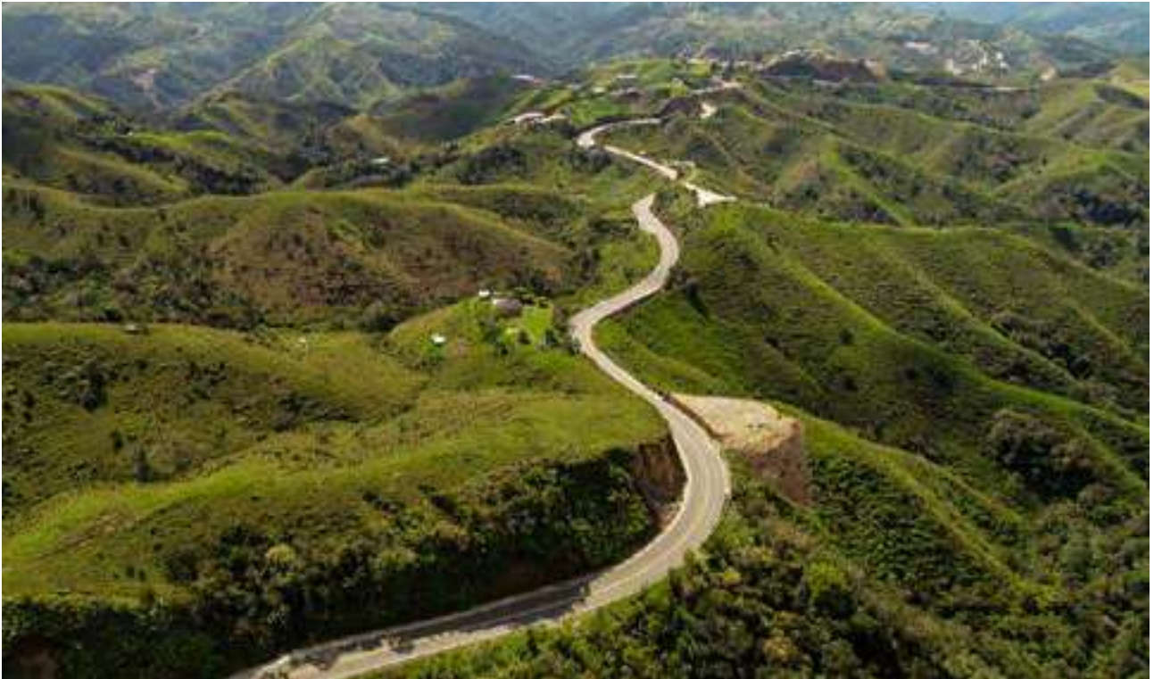
Pavimentación vía Anorí - Ye de Anorí - El Mango. Nordeste, municipio de Anorí. Secretaría de Infraestructura Física.
