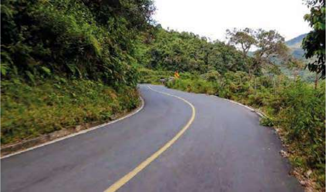
Pavimentación vía La Quebra – Argelia. Oriente, municipio de Argelia. Secretaría de Infraestructura Física.
