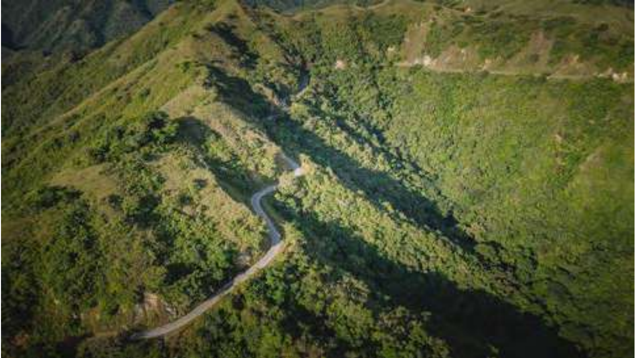
Pavimentación vía La Usa - Caicedo. Occidente, municipio de Caicedo. Secretaría de Infraestructura Física.
