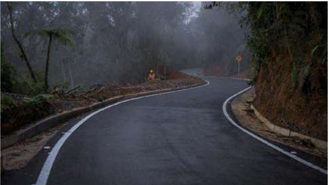
Pavimentación vía Uramita – Peque. Occidente, municipio de Peque. Secretaría de Infraestructura Física.
