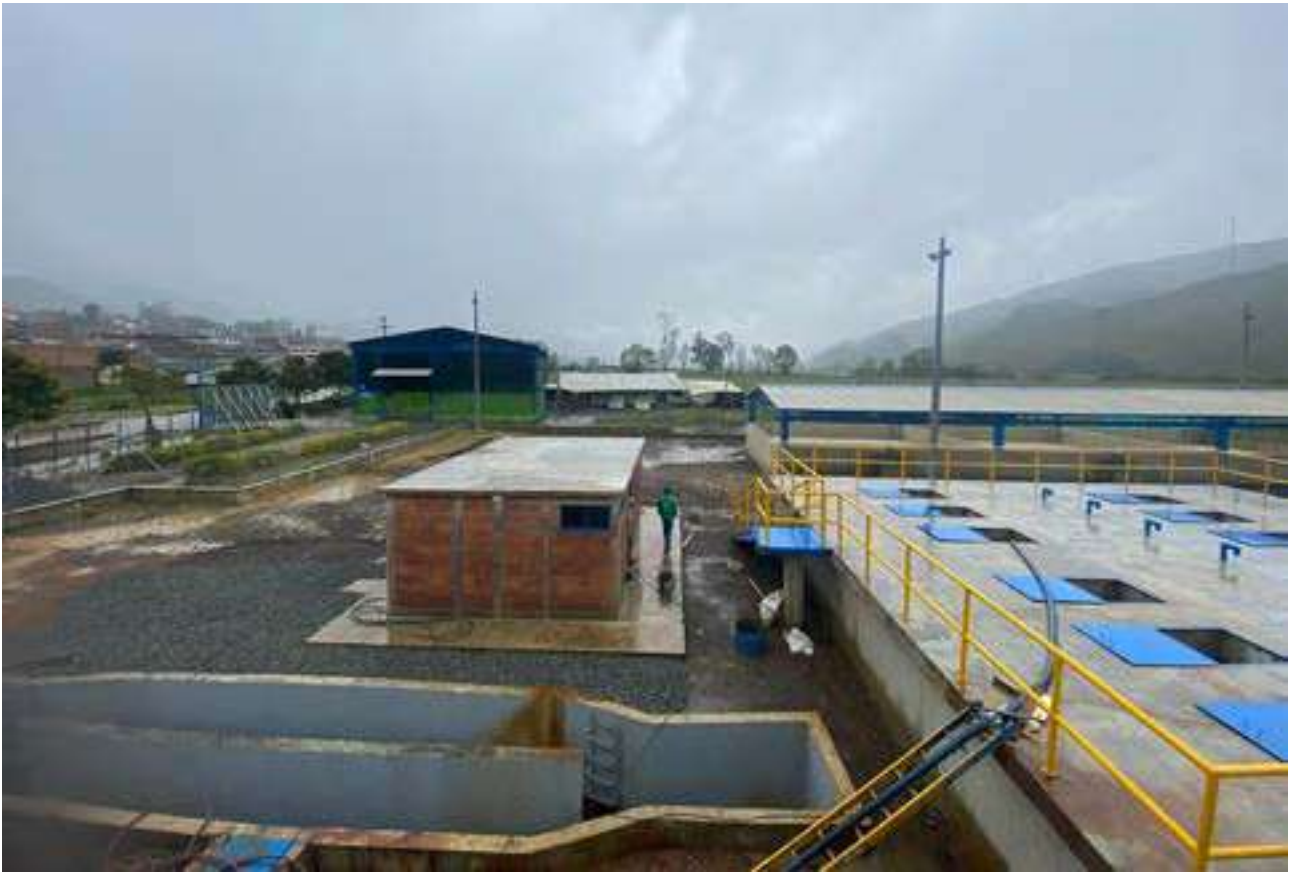
Construcción de planta de tratamiento de aguas residuales y redes de alcantarillado. Suroeste de Antioquia, municipio de Urrao. Gerencia de Servicios Públicos.
