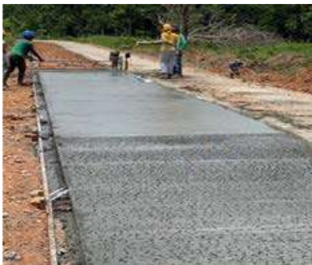
Obras en desarrollo en el aeródromo del municipio de Necoclí. Urabá, municipio Necoclí. Secretaría de Infraestructura Física.
